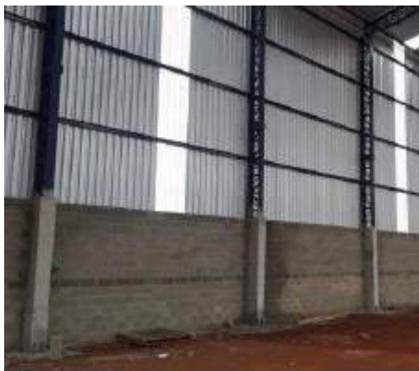
Figura 2 - Fechamento em estrutura metálica.
