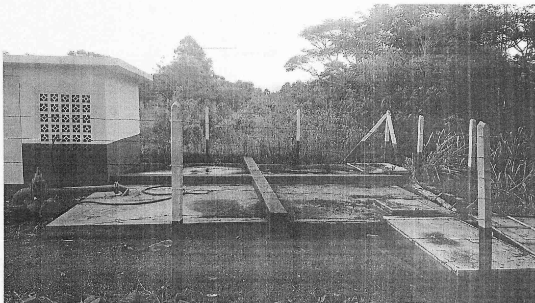
Fig. 04 Reservatório subterrâneo Mercedes.
